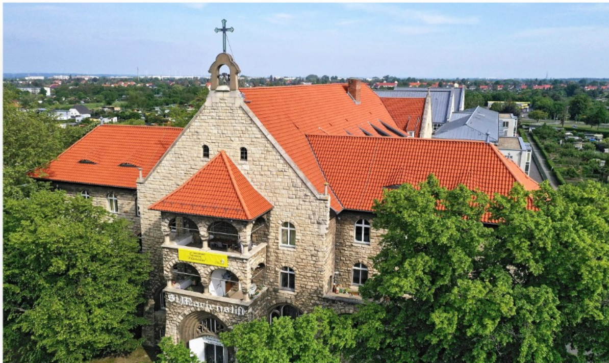
Teil des Haupteinganges (Altbau) und im Hintergrund der Neubau des Krankenhauses St. Marienstift Magdeburg
